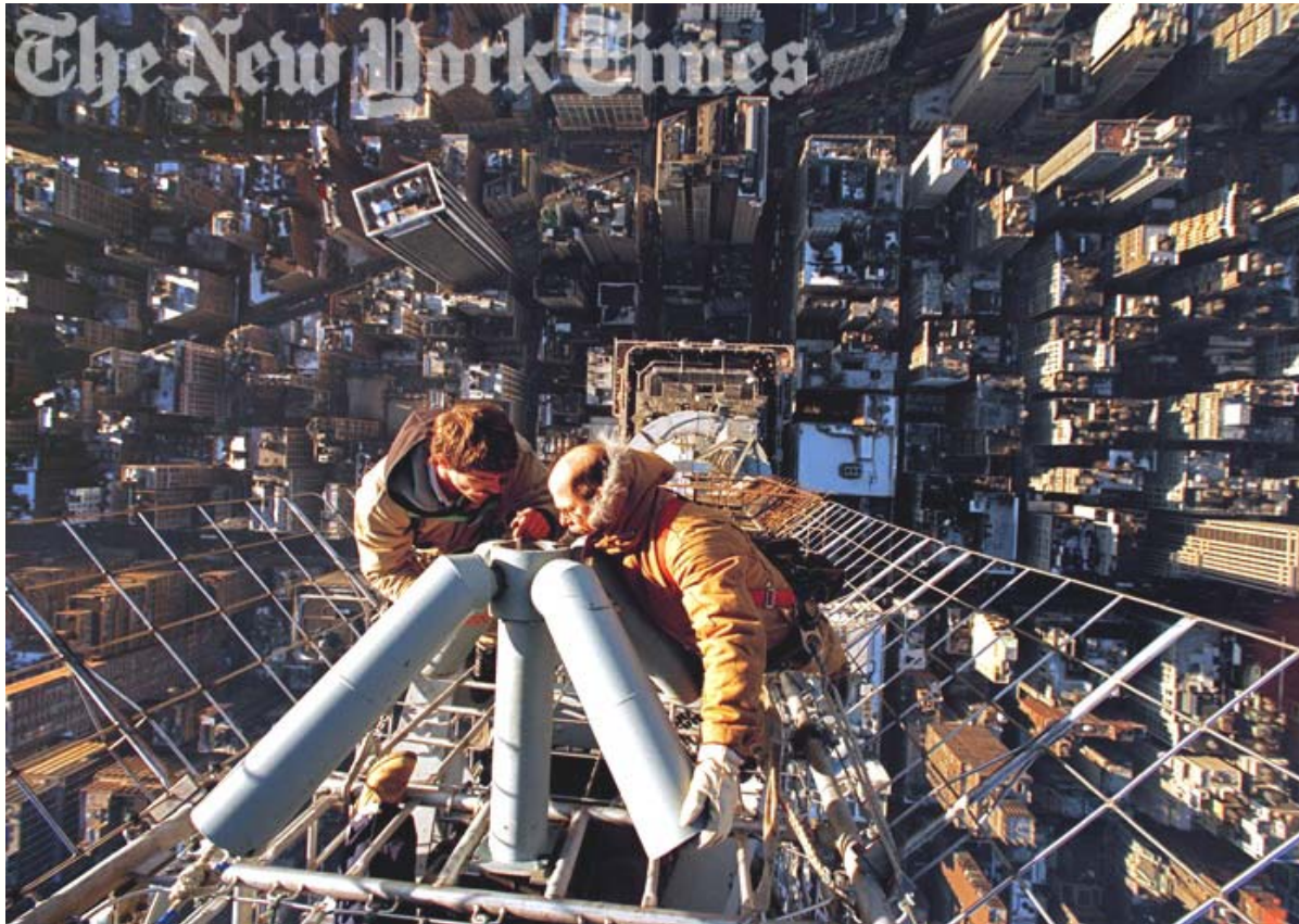
Installateurs d'antennes UHF au sommet de l'Empire State Building (New York)
