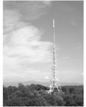
Emetteur du Belvédère Altitude au pied : 345 m Hauteur du pylône : 194 m
